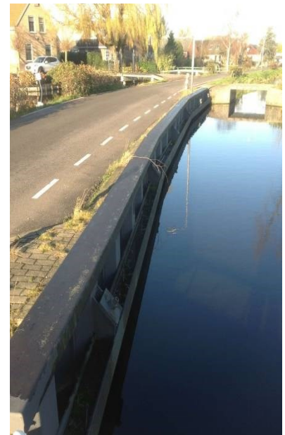
Figuur 1: Stalen damwand
